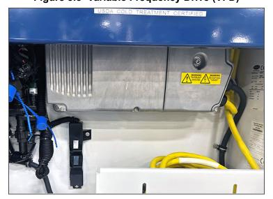
Figure 3.8 Variable Frequency Drive (VFD)
