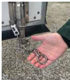
Obrázek 5.1.25 Bezpečnostní řetěz je umístěn ve spodní části dveří.
