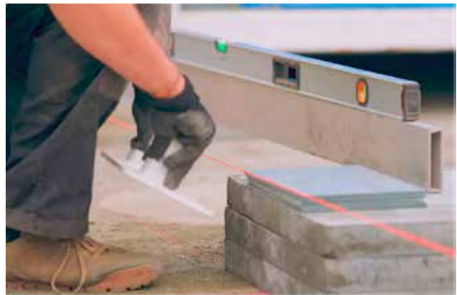
Vorbereitung der Stützen
