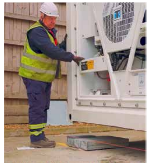
Τοποθέτηση στην τελική θέση
