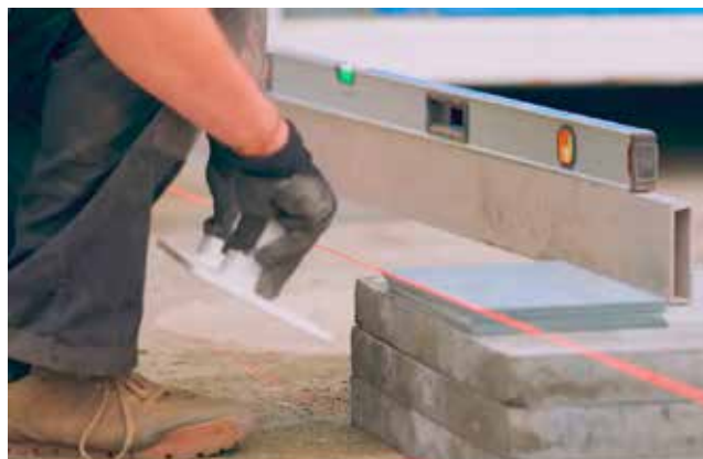
Préparation du support
