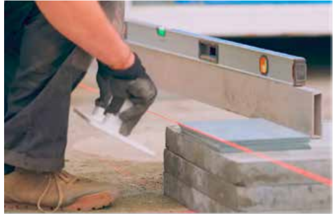
Preparazione del supporto
