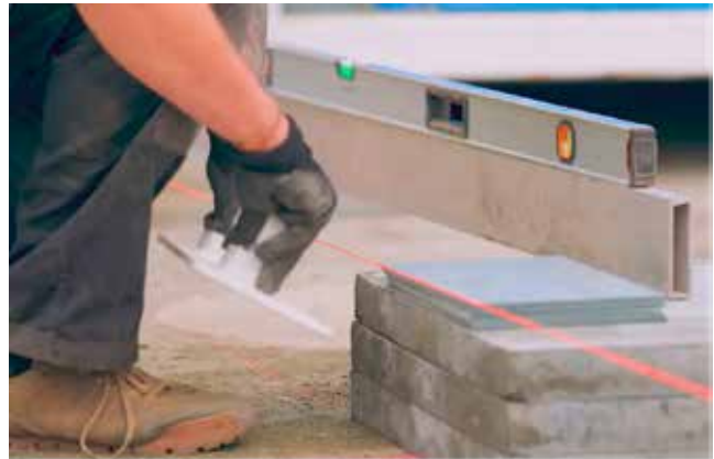
Vorbereiding van de ondersteuning
