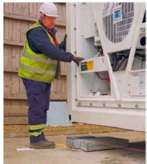
Plaatsing op de definitieve locatie
